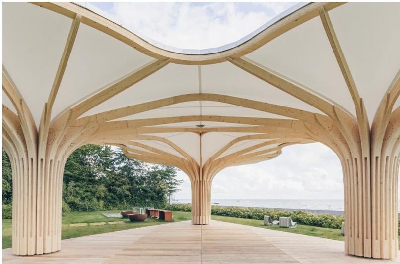
Les trois structures porteuses se développent ensemble et se rejoignent pour former le toit.
