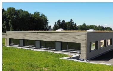
Le deuxième étage de l'aile des bureaux ainsi que le toit du bâtiment ont une construction à ossature bois.
