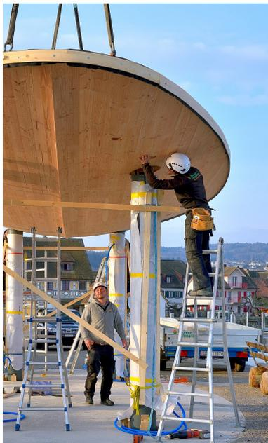
Grâce à des gabarits de montage et à des supports en acier fabriqués avec précision, le toit a pu être mis en place sans aucun problème.
