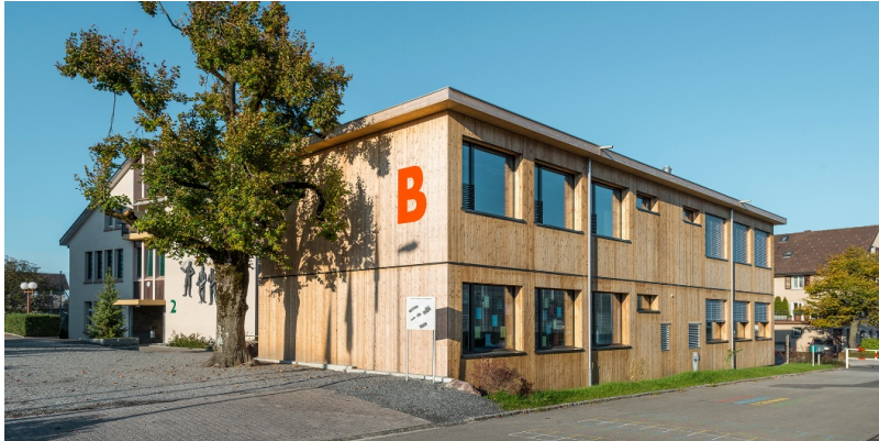
Zweigeschossiger Modulbau mit Holzfassade
