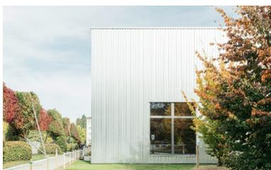
Die Fassaden und das Dach sind mit Trapezblech abgedeckt.
