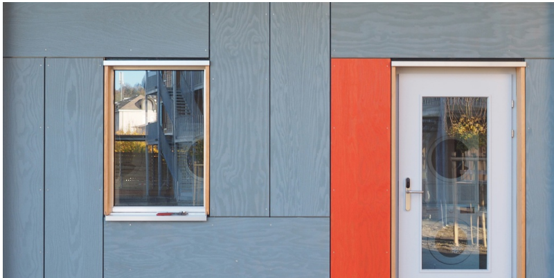
Detailansicht Fassade in Grau und Rot
