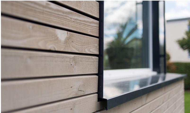
Die Fassade des neuen Anbaus besteht aus vorvergrautem Lärchenholz und stellt die optimale Wärmedämmung sicher.
