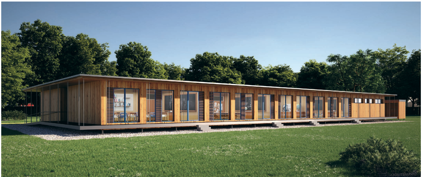
Bild 2. Holzmodulbau in Berlin-Tempelhof (hier als Schule): 28 Module bilden ein Gebäude von 42 m Länge, 18 m Breite und 3 m Höhe (Bild: MK Design and Visualization Studio)
