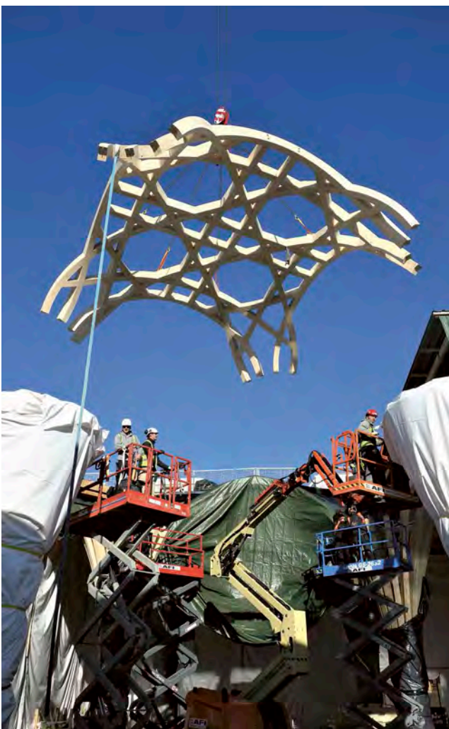
7 Zusammengesetztes Gewölbeteil am Kranhaken.
