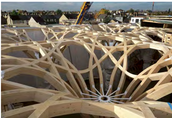
9 Blick in das noch offene Tragwerk von oben.
