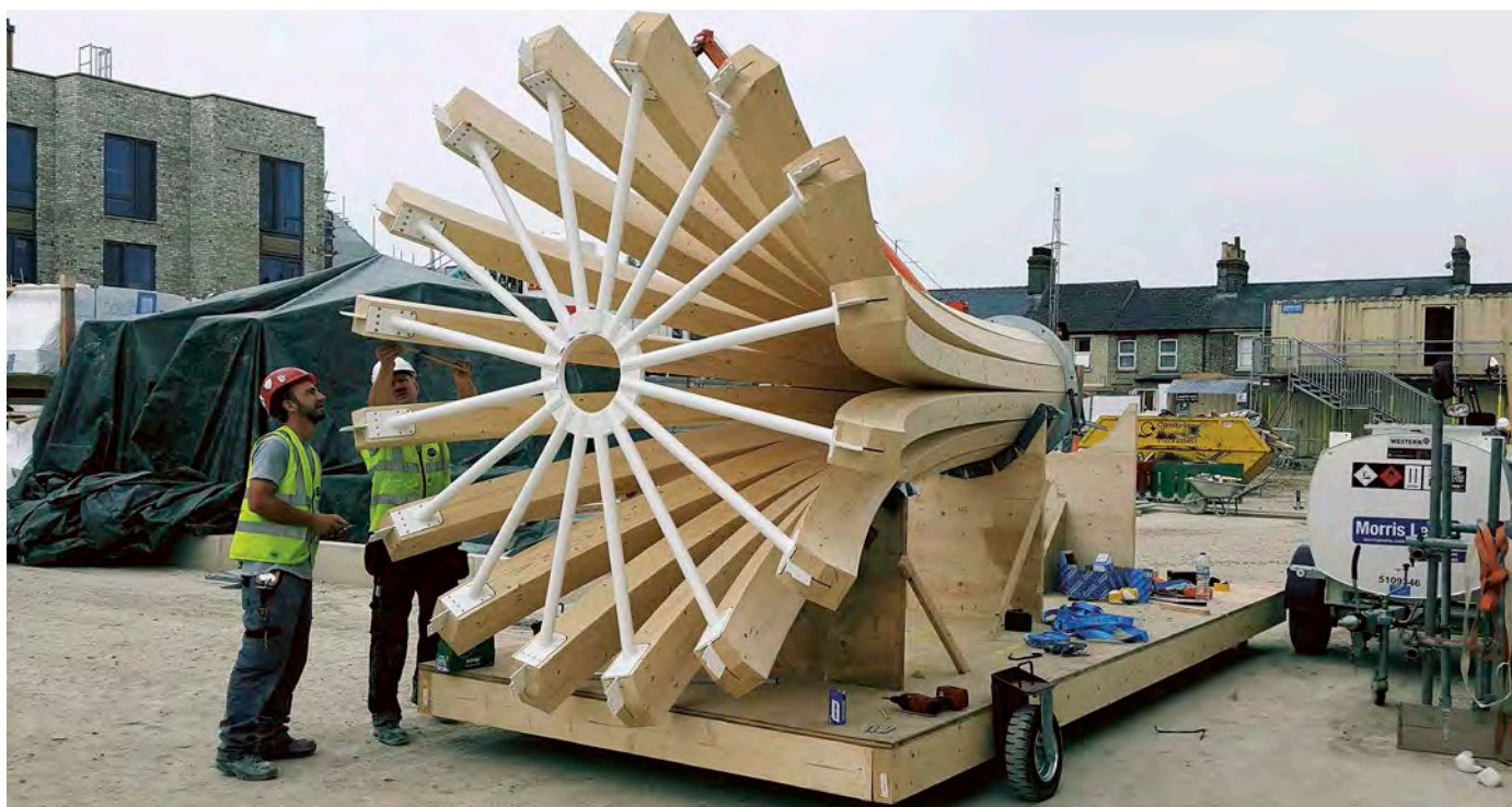
11 Auch die Anlieferung der Einzelteile machte eine exakte Planung notwendig.
