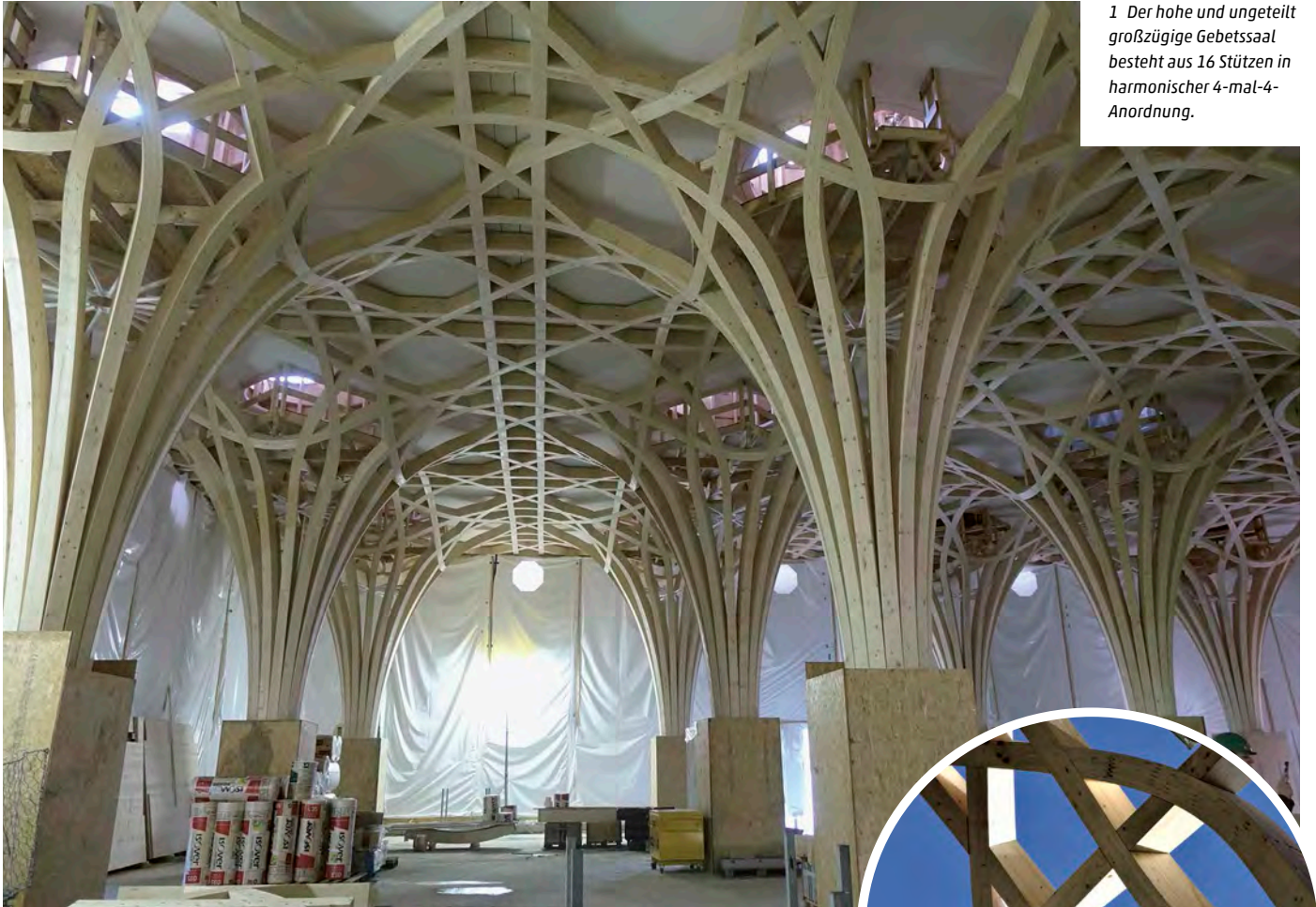
2 Die vielfachen, zweisinnigen Rundungen und Verschlingungen des Gewölbes stellen eine erhebliche Herausforderung dar.
