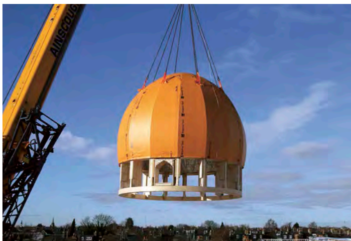
8 Die Kuppel beim Einschweben.
