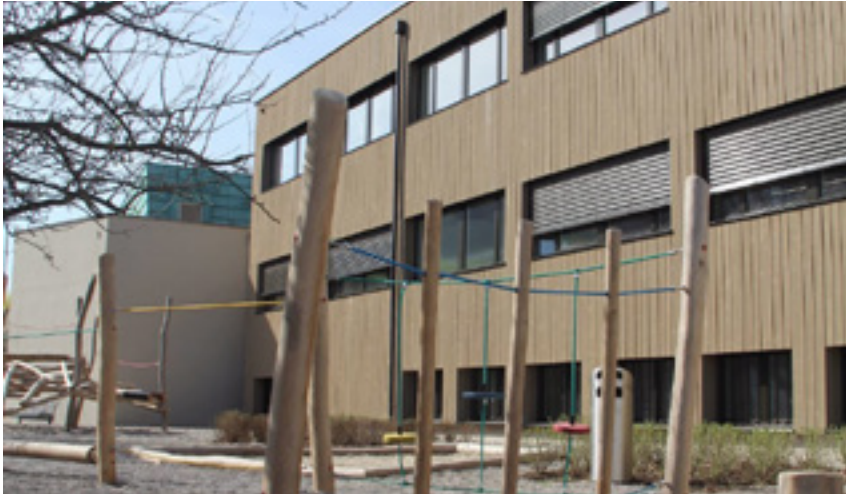
Schulhaus Arisdorf (Häring & Co. AG)
