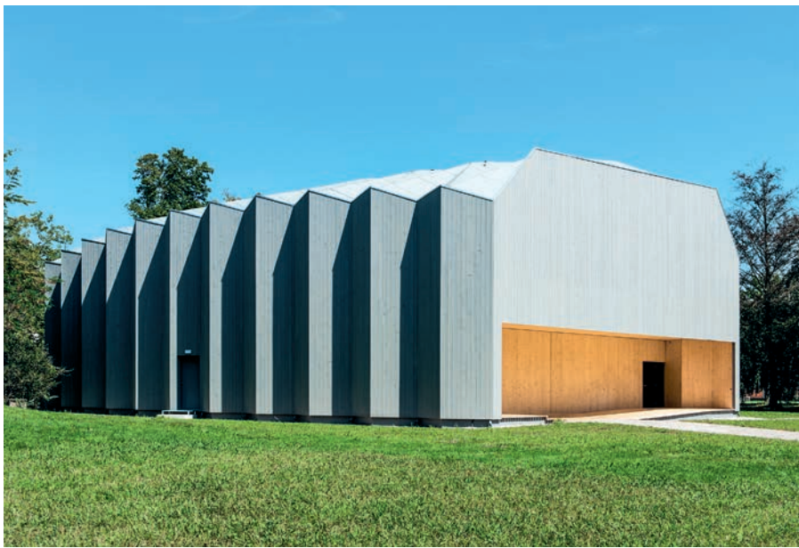
10 Le pavillon du Théâtre Vidy-Lausanne frappe par sa façade plissée.
