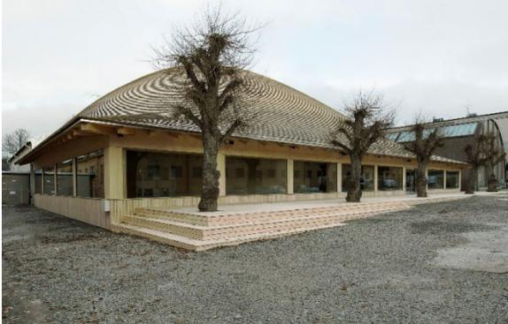
Vorgängige Mock-ups, die parametrische Planung am 3D-Modell sowie die traditionelle Holzbautechnik mit Dübeln und Zapfen führten zu zuverlässig umsetzbaren Konstruktionslösungen.
