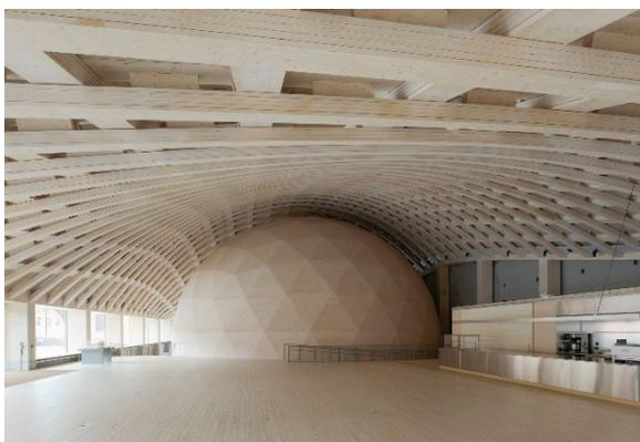
Der Kuppelbau mit 3D-Kino befindet sich im Innern einer Holzkonstruktion mit freigeformtem Dach.
