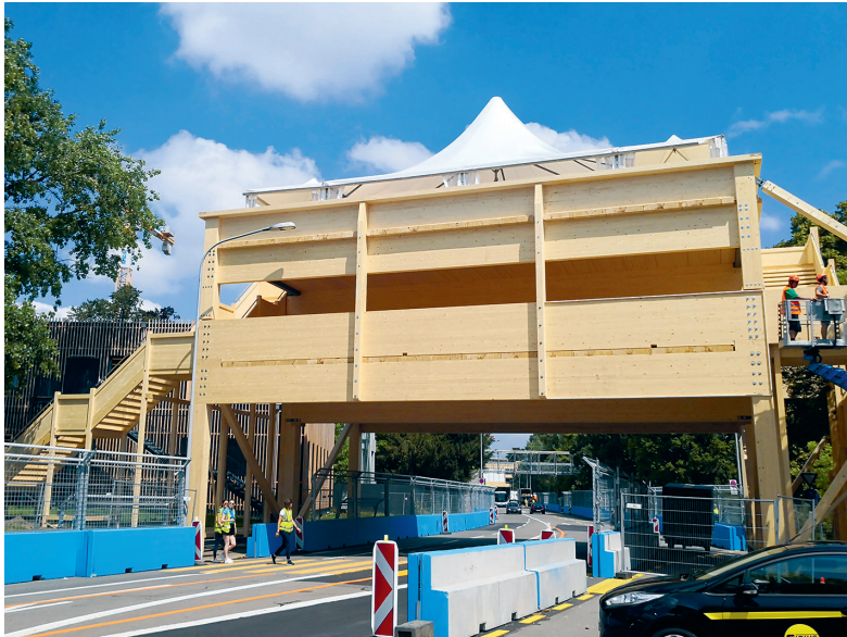
Für die Montage der Fly-Over Bridge waren zwei Tage geplant.
