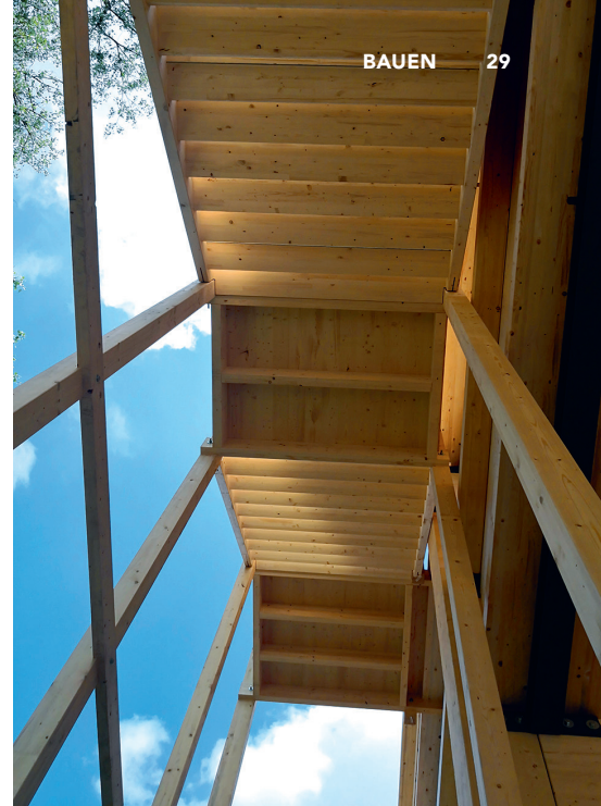
Blick von unten auf den Treppenzugang zur Hospitality-Einheit «Fly-Over Bridge».
