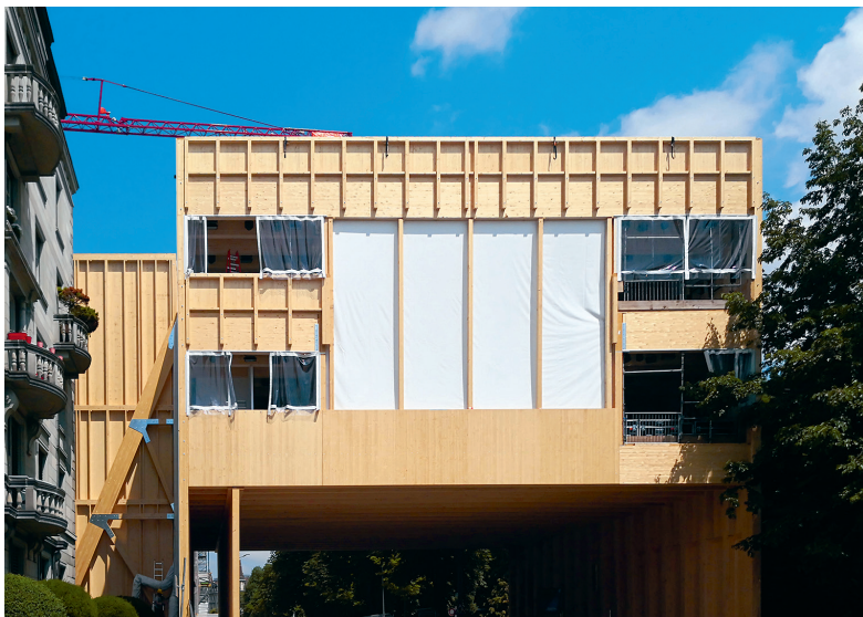
Acht Tage waren für die Montage des knapp 16 Meter hohen E-Cube vorgesehen. Von hier aus konnten die Gäste direkt auf die unter ihnen liegende Startlinie blicken.
