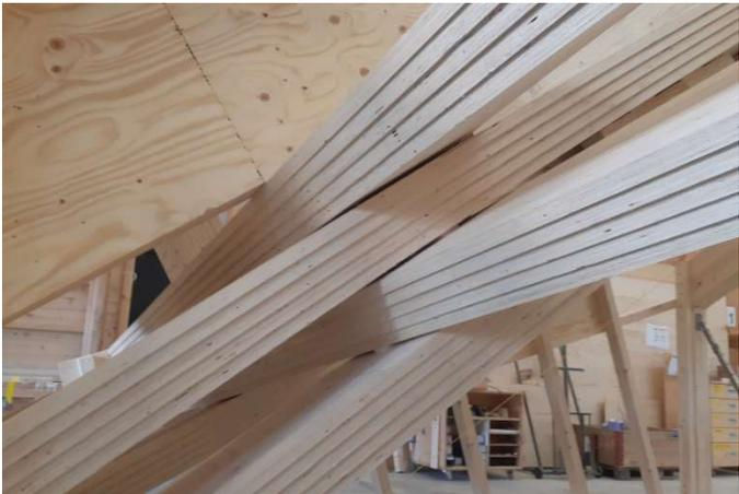
Als Gitterschale zusammengesetzt, überspannen die Träger aus Fichten-Furnierschichtholz, (Laminated Veneer Lumber/LVL). Insgesamt werden 20 Kilometer LVL-Plattenstreifen im Gitterrost des Dachtragwerks verbaut.
