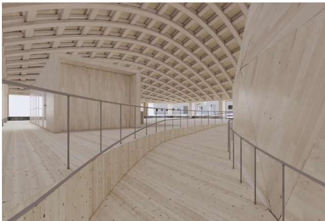
Das Main Roof besteht aus einer FreeForm-Konstruktion, die eine Grundfläche von 25 x 48 Metern überspannt. Zusammen mit ihren Partnern übernahmen die Freiform-Spezialisten von Blumer Lehmann Planung, Produktion und Ausführung der hochkomplexen Dachgeometrie.
